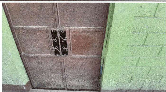
Foto 3: Sustrucción de puerta de metal, por puerta de metal. ( 4 Puertas de aulas)
