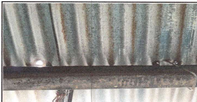
Foto: Sustrucción de costanera de metal, por de metal.
